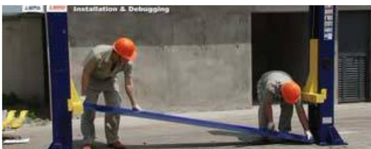
12. Проверьте еще раз расстояние между стойками согласно чертежу.
