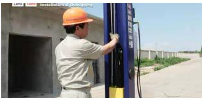
14. При установке зубчатой рейки сперва открутите блок, не доходя 2 см до конца винта, вытащите шпильку и пружину, установите рейку на предназначенное место, вставьте пружину и шпильку.
