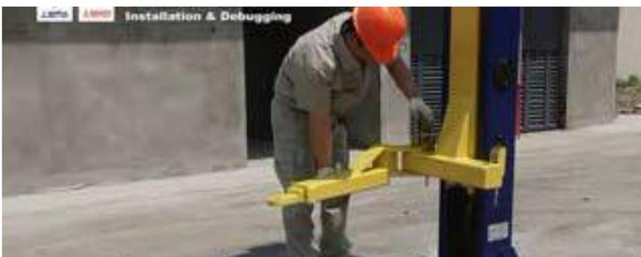
18. Отрегулируйте устройство зубчатого стопора, соедините стопоры с лапами, хорошо затяните гайки.
